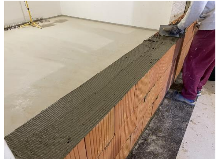
Aplikace finální akustické zdicí malty ve zkušebně D-AKUSTIKA
