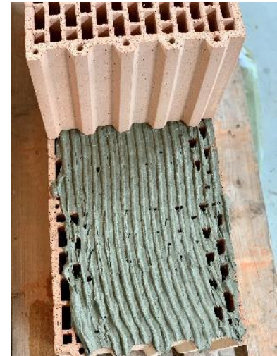
Aplikace na keramickou tvarovku
